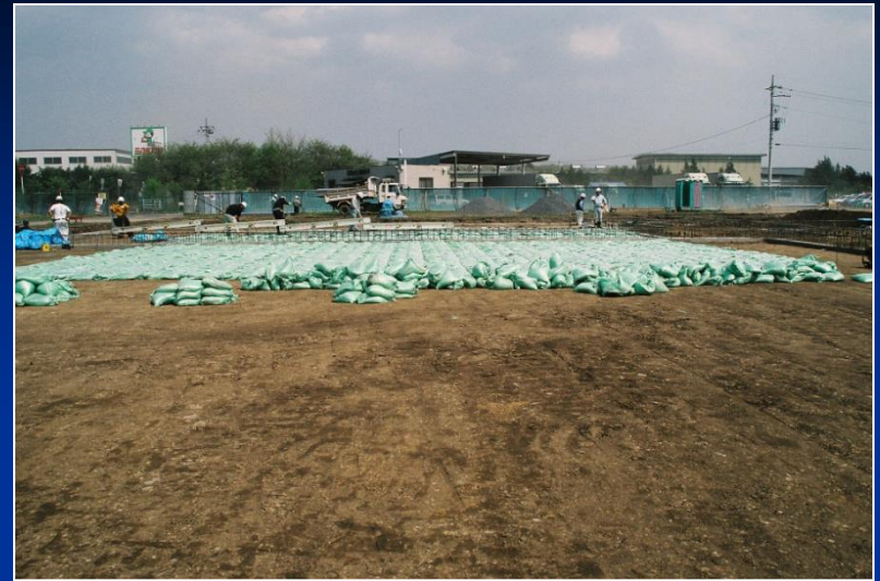
倉庫土間(ラック倉庫)土嚢採用
