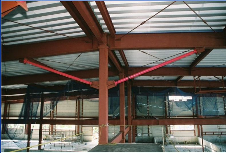
油圧ダンパー6基(長さ5m)を採用
