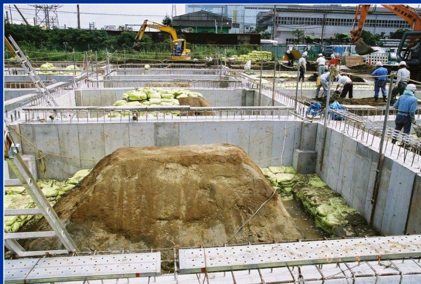
地中梁側面の埋戻しに土嚢2列20段 (全体土嚢数20万袋使用)
