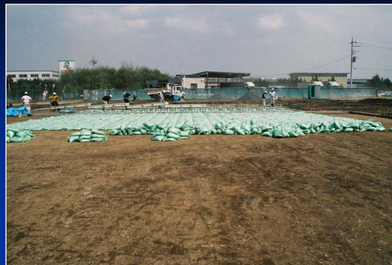
倉庫土間(ラック倉庫)土嚢採用
