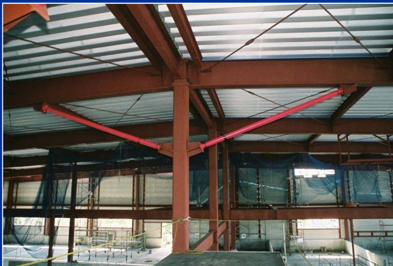
油圧ダンパー6基(長さ5m)を採用
