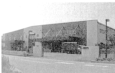
写真1 建物正面外観 Photo 1 Front elevation
