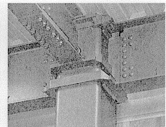
写真4 既製の外ダイヤフラム柱頭部 Photo 4 External stiffener rings of column head
