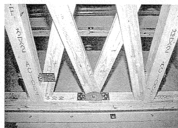
④筋かい+GVA下部ダンパー
