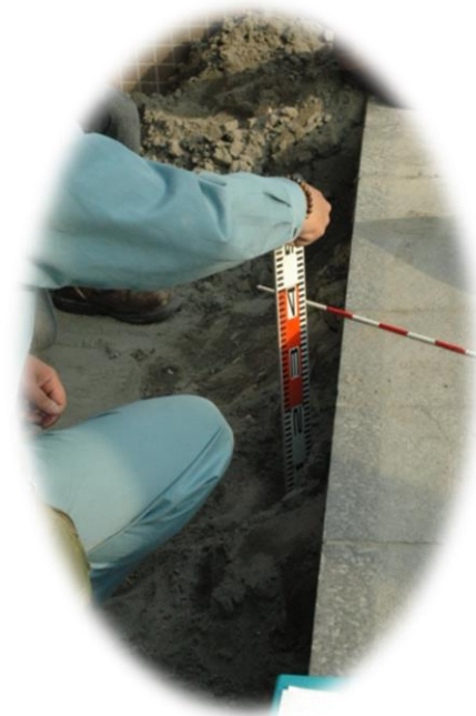
直接基礎構造物は道路面よりさらに40cm沈下
