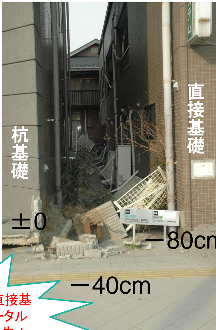
直接基礎構造物は道路面よりさらに40cm沈下
