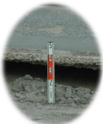
道路面は杭基礎構造物より40cm沈下
