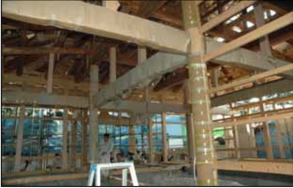
地上部拝殿躯体
