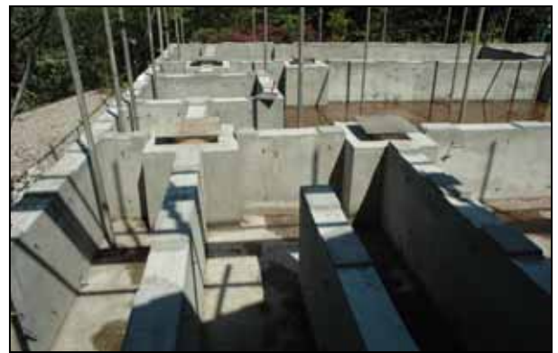
基礎工事完成
