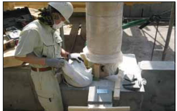
柱脚グラウト作業 廃ガラスカレット充填
